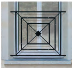
Le garde corps acier
